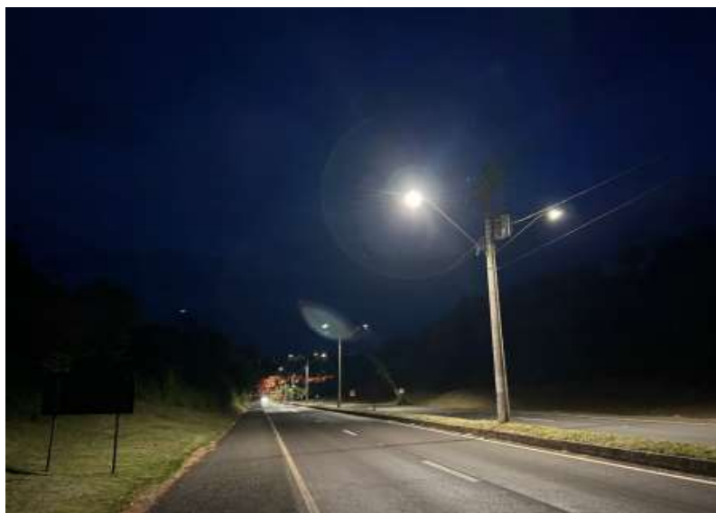
Figura 58 - Iluminação da Estrada Municipal Pedro Bosco
