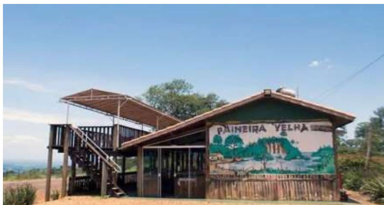
Figura 23 - Vista lateral do Mirante Paineira Velha
