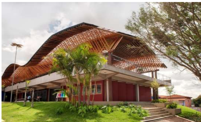
Figura 36 - Vista lateral parcial do CMFCS
