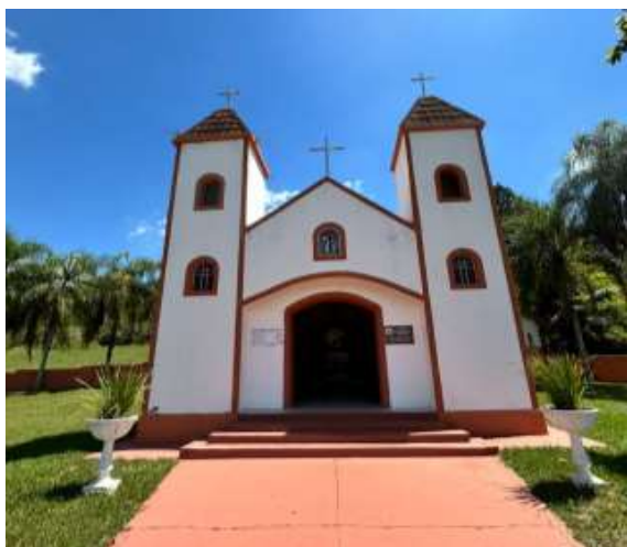
Figura 33 - Vista frontal da Capela de Nossa Senhora Aparecida
