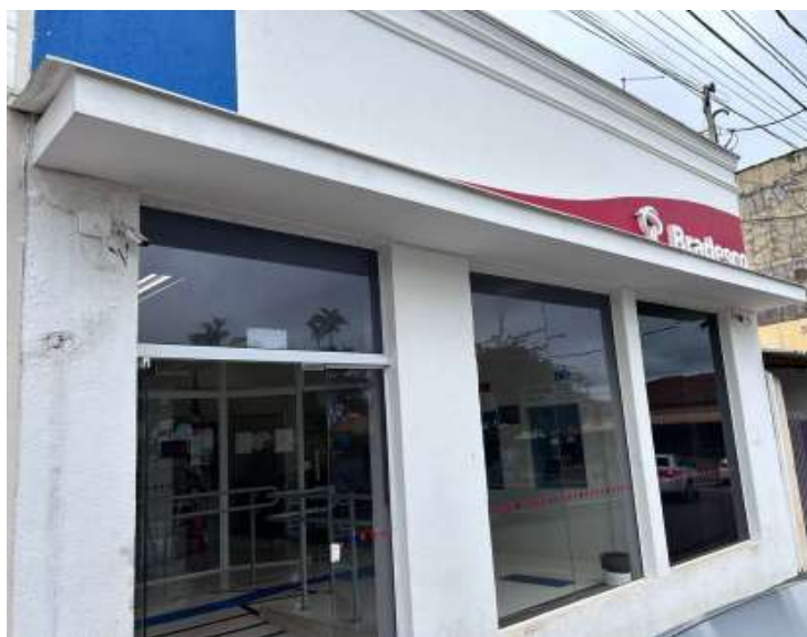
Figura 14 - Fachada do Banco Bradesco – Agência Pardinho
