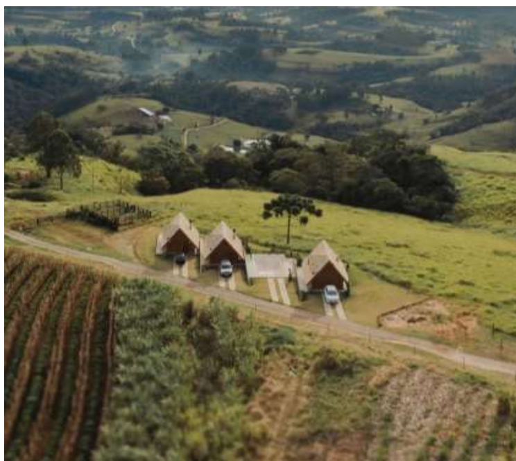
Figura 8 - Vista aérea do Chalés do Gigante
