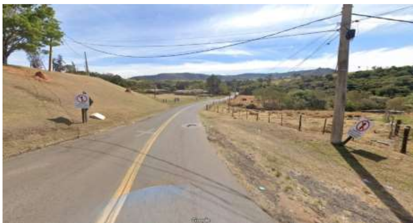
Figura 50 - Trecho inicial da Estrada Municipal João Emílio Roder
