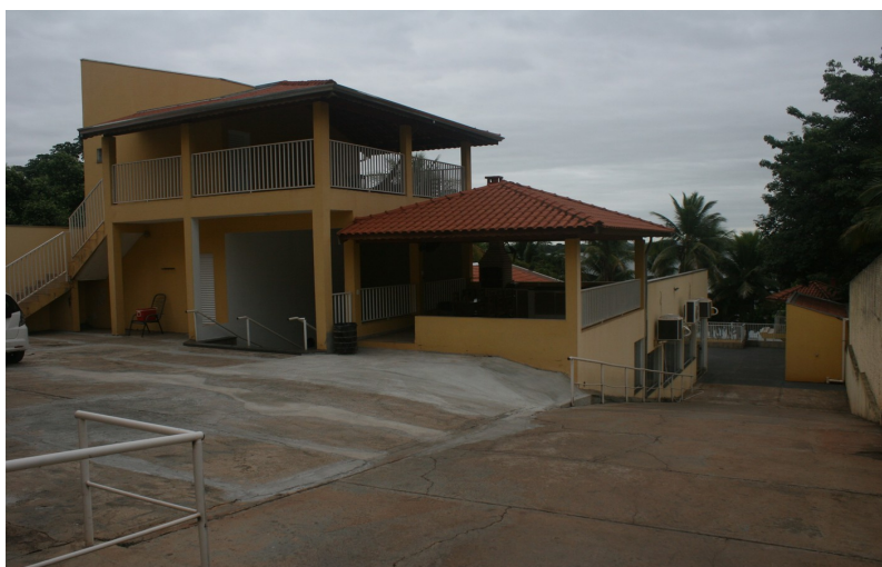
Figura 75: fachada interna da Pousada Sol
