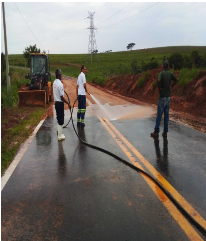
AGENTES DE PROTEÇÃO E DEFESA CIVIL E DEPARTAMENTO DE OBRAS
