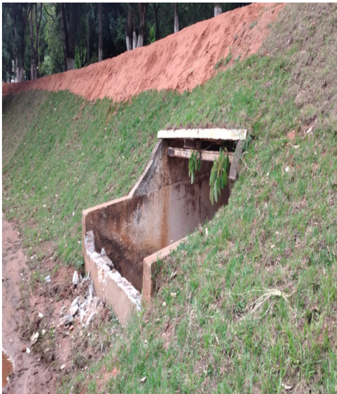
VERTEDOIRO EM MANUTENÇÃO
