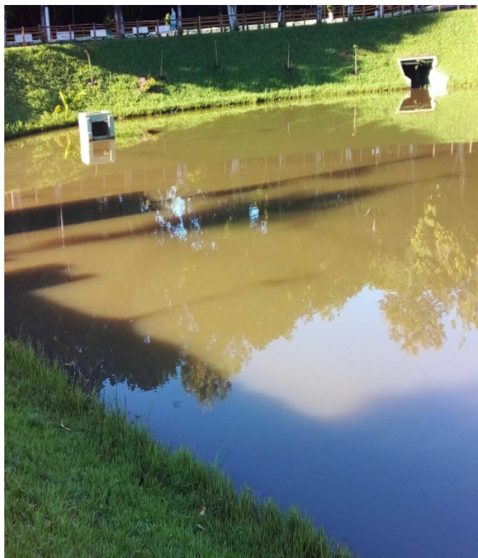
VERTEDOIRO E EXTRAVASOR EM FUNCIONAMENTOS
