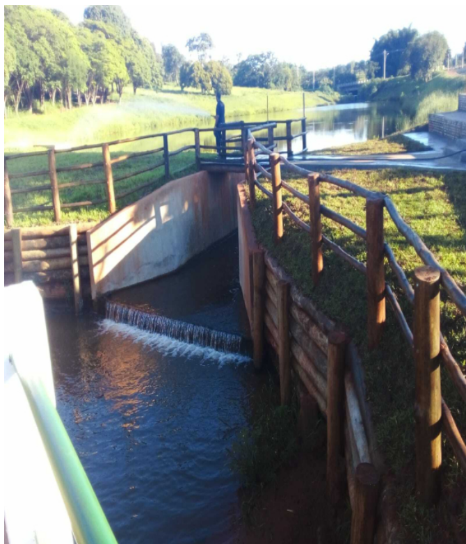
VERTEDOIRO HILDERGARD LOOSLI
