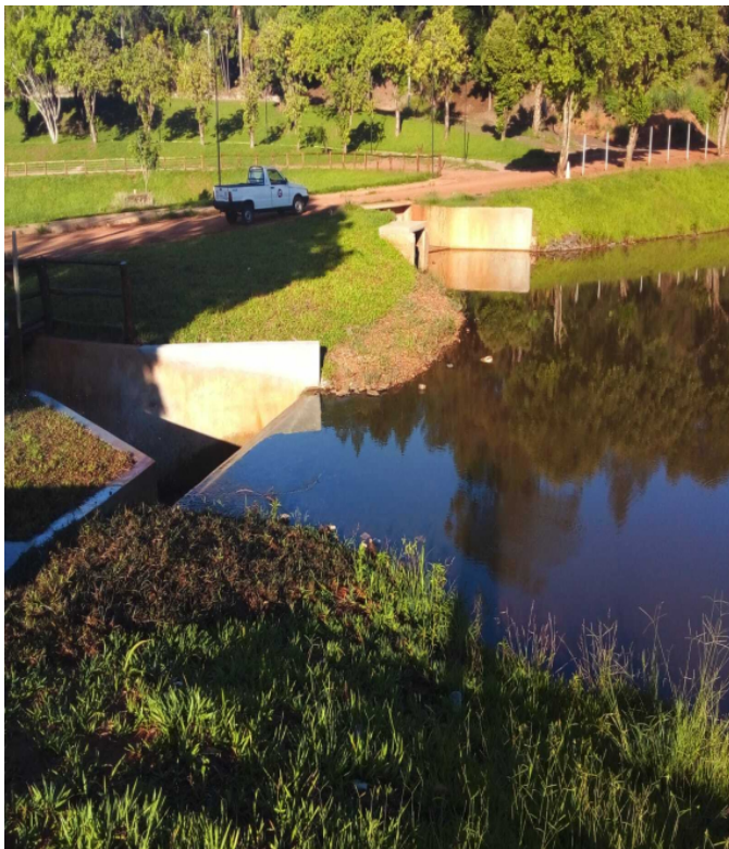
VERTEDOURO E EXTRAVASOR EM FUNCIONAMENTOS
