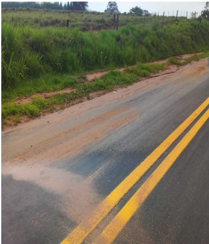
SISTEMA DRENAGEM ASSOREADOS
