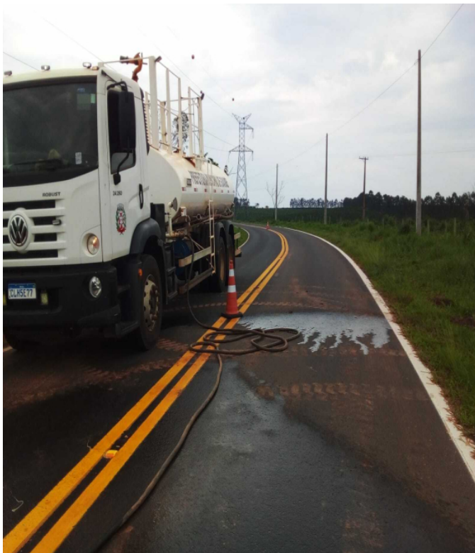
CAMINHÃO PIPA MUNICIPAL
