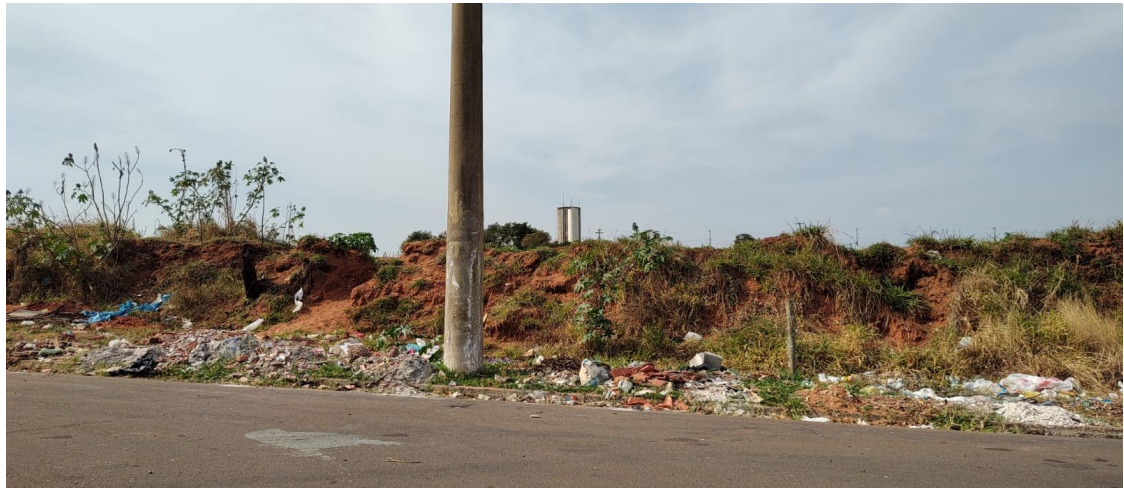
Imagem 16 – Ponto de descarte de RCC de forma irregular. Fonte: eBio, 2023.
