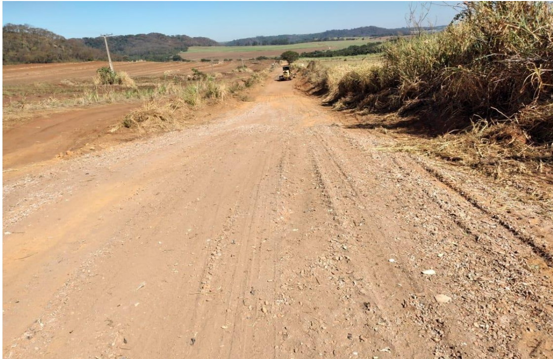
Imagem 23 – vista de estrada que recebeu melhorias com o uso dos RCC.
