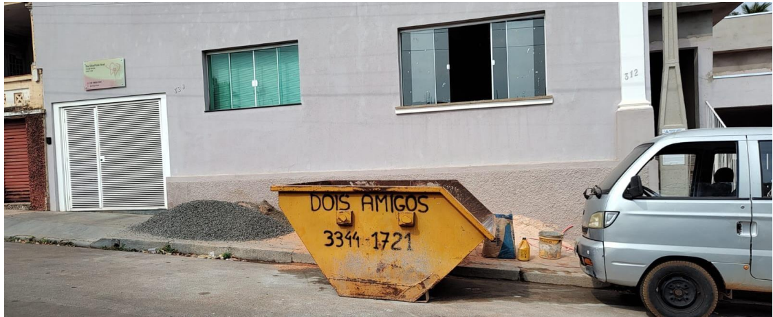
Imagem 14 – Resíduos da Construção Civil dispostos em caçambas. Fonte: eBio, 2023.
