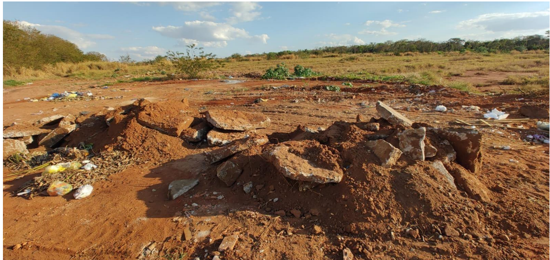
Imagem 20 – Resíduos da Construção Civil (Classe A) dispostos em área de transbordo. Fonte: eBio, 2023.
