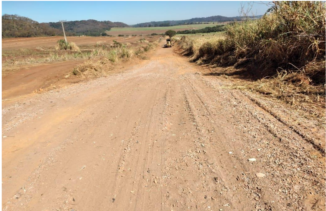
Imagem 24 – vista de estrada que recebeu melhorias com o uso dos RCC.
