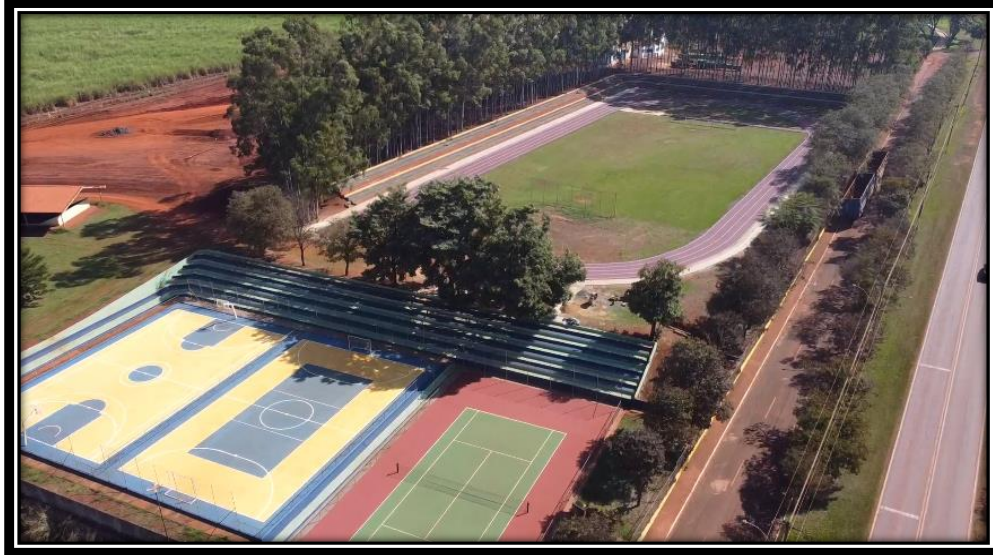
Obras no Centro de Lazer Oscar Vaz de Almeida Fonte: Prefeitura Municipal de Jaborandi
