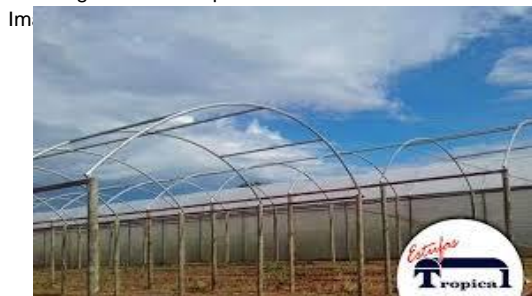
Imagem 2 . Arcos para estrutura
