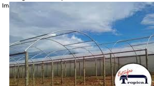
Imagem 2 . Arcos para estrutura
