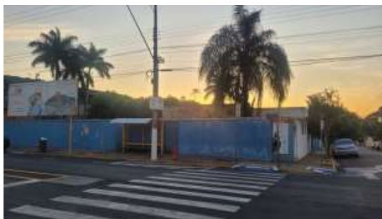
Foto 03 - Testada do Imóvel com frente para a Avenida Tamoios
