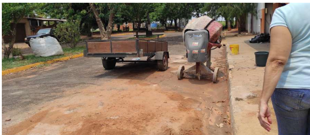
Figura 10: Carretinha contratada para transporte de material de obra.
