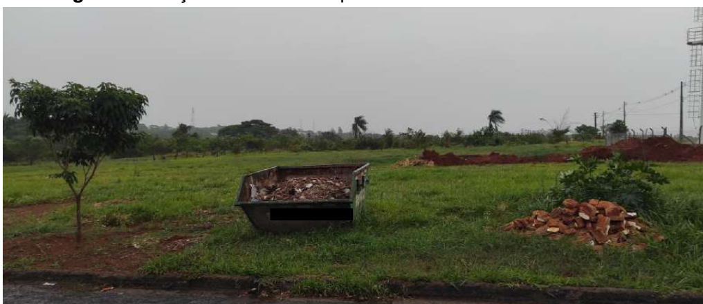
Figura 09: Caçamba contratada para o acondicionamento de resíduos.
