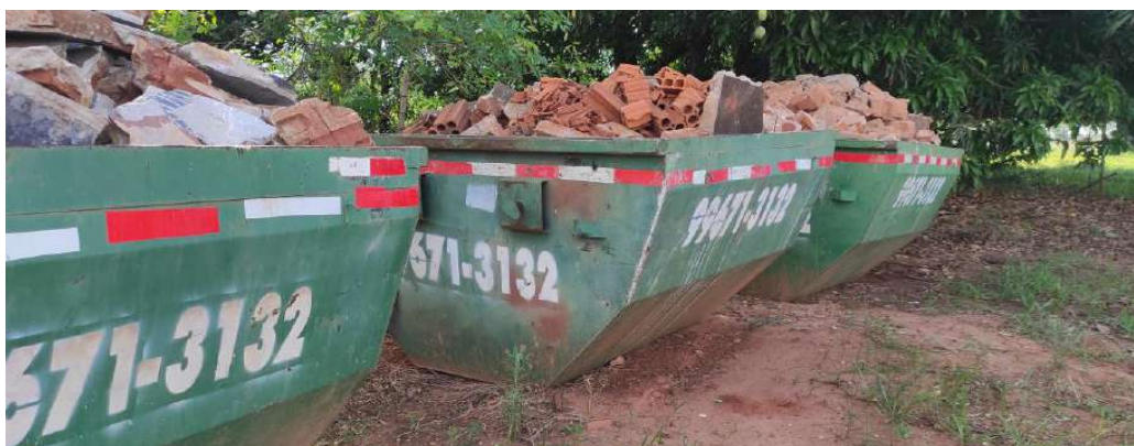
Figura 19: Caçambas alugadas com capacidade para 3m 3 .
