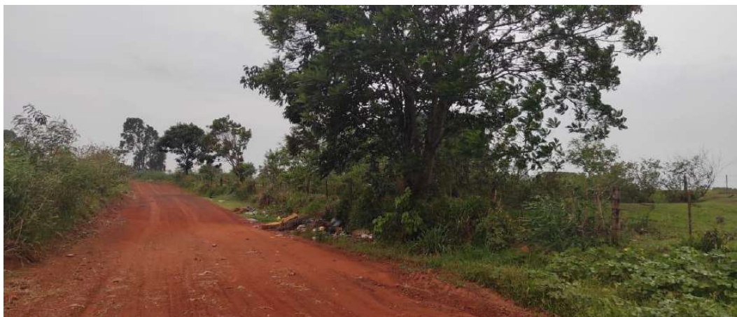
Figura 44: Beira da via MTO 030 – Ponto 03.
