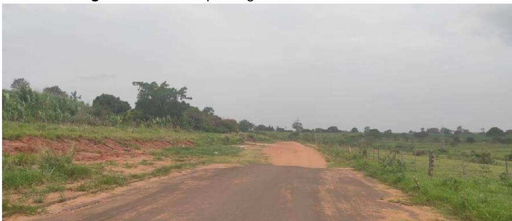
Figura 35: Vista do prolongamento da Rua José Nastari.
