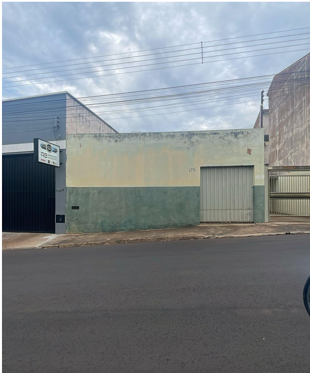
Galpão vazio, fora de uso comercial no momento.
