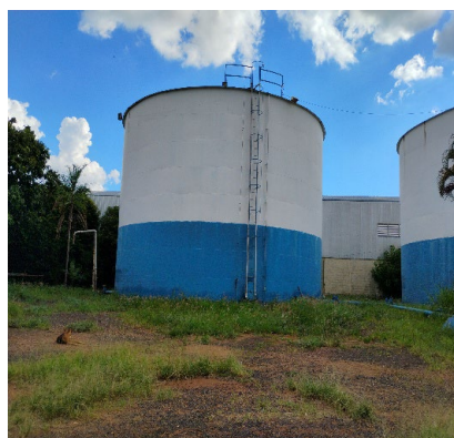
RESERVATORIO R11 - RESERVATORIO APOIADO
