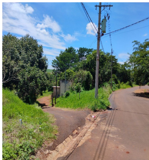
BRODOWSKI SANEAMENTO CONTENDAS I
