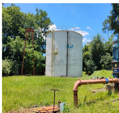
RESERVATORIO R1 - RESERVATORIO APOIADO
