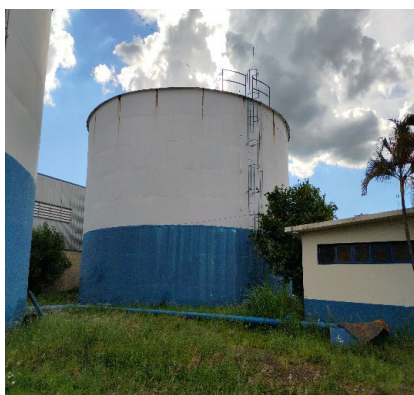
RESERVATORIO R12 - RESERVATORIO APOIADO
