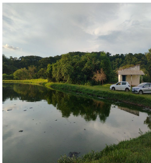
BRODOWSKI SANEAMENTO ETE DA DIVISA
