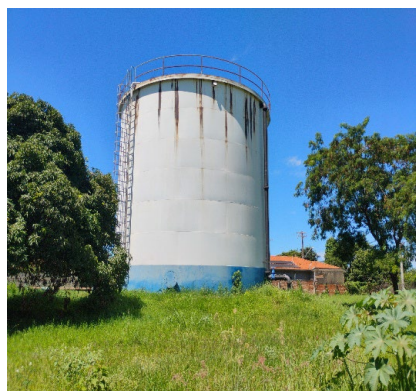
RESERVATORIO R2 - RESERVATORIO APOIADO
