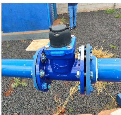
POCO BELAS ARTES - MEDIDOR DE VAZAO
