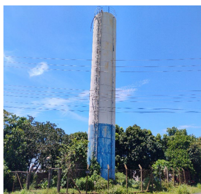
RESERVATORIO R7 - RESERVATORIO APOIADO ELEVADO
