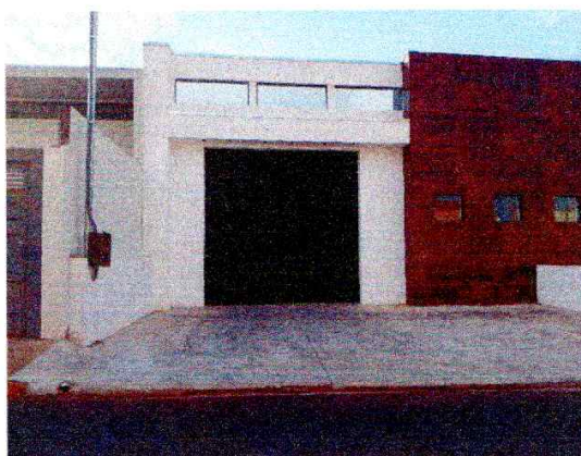
FOTO 01 VISTA FRONTAL DO DEPÓSITO LOCALIZADA NA RUA MIGUEL GANTUS (COMÉRCIO PRÓXIMO)
