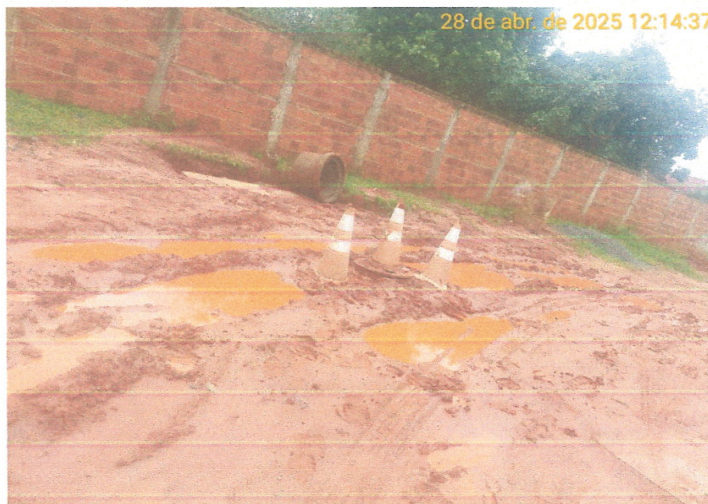
Foto 01 – Deslocamento de Tampa de PV 01 localizado na Rua “21”
