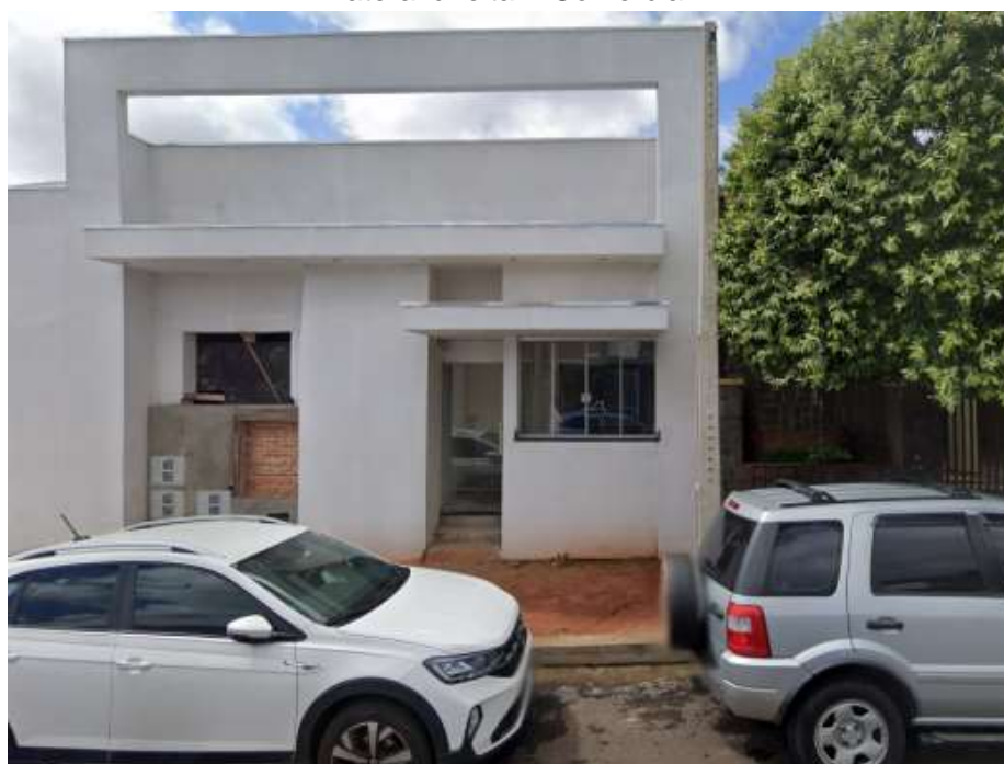
Lateral esquerda - Comercial em construção
