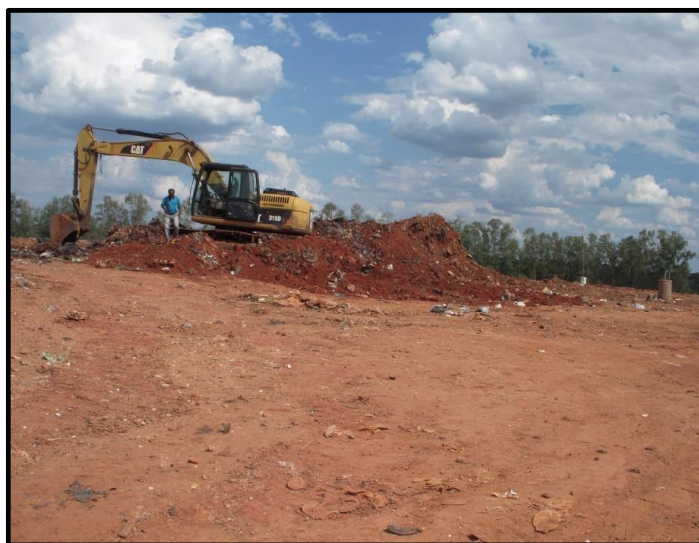
Aterro Sanitário Municipal Execução do tratamento por cobertura e aterro dos resíduos domiciliares descartados
