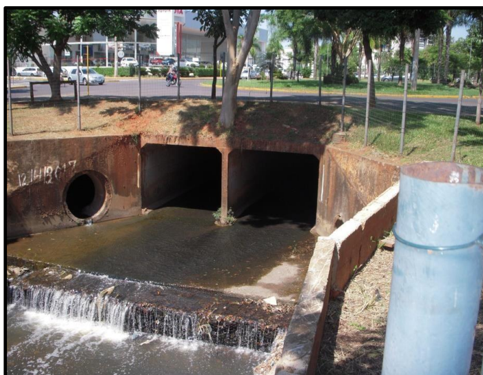
Córrego Machadinho – Trecho em galeria de duas células Necessita reforço de mais uma célula
