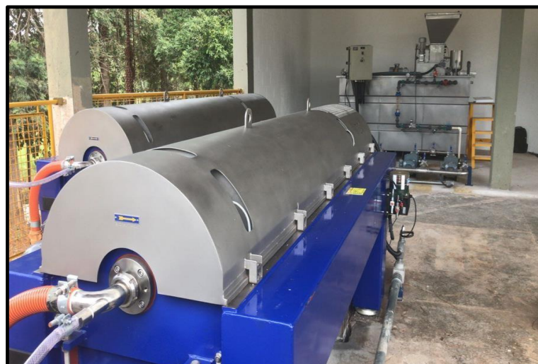
Estação de Tratamento de Esgotos Bagaçu Moderno processo de desidratação do lodo – 2018
