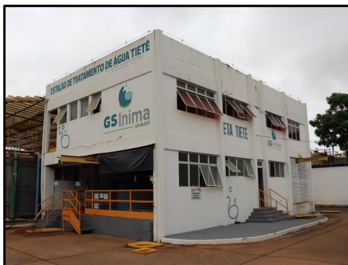
Sistema Produtor Tietê ETA Tietê – Remodelada em 2018
