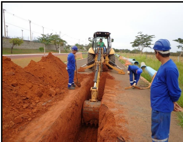
Obras em vias públicas Processo convencional
