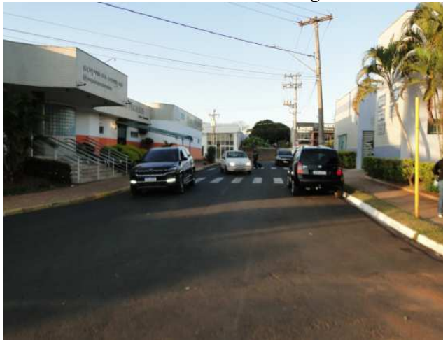
FOTO 01 Vista da fachada do Colégio
