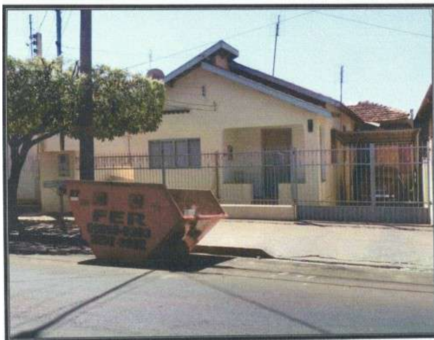
Figura 9: Caçamba com capacidade de 3m³ para entulho
