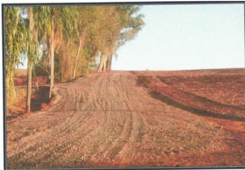
Figura 14: Estrada Municipal recuperada com RCC triturado
