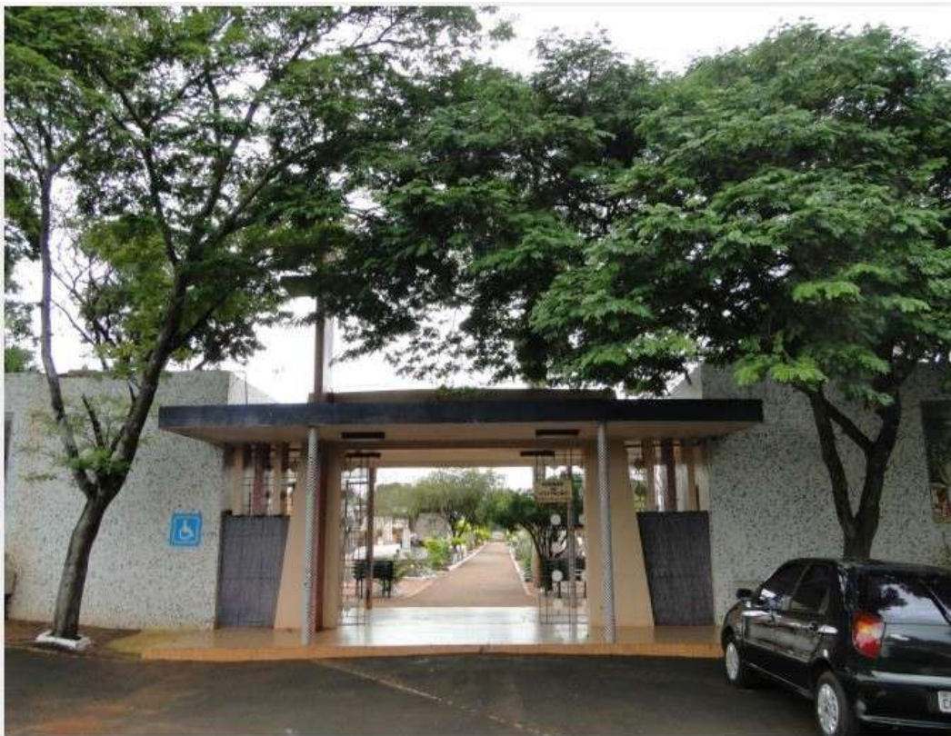
Foto 16 - Vista entrada principal do cemitério municipal
