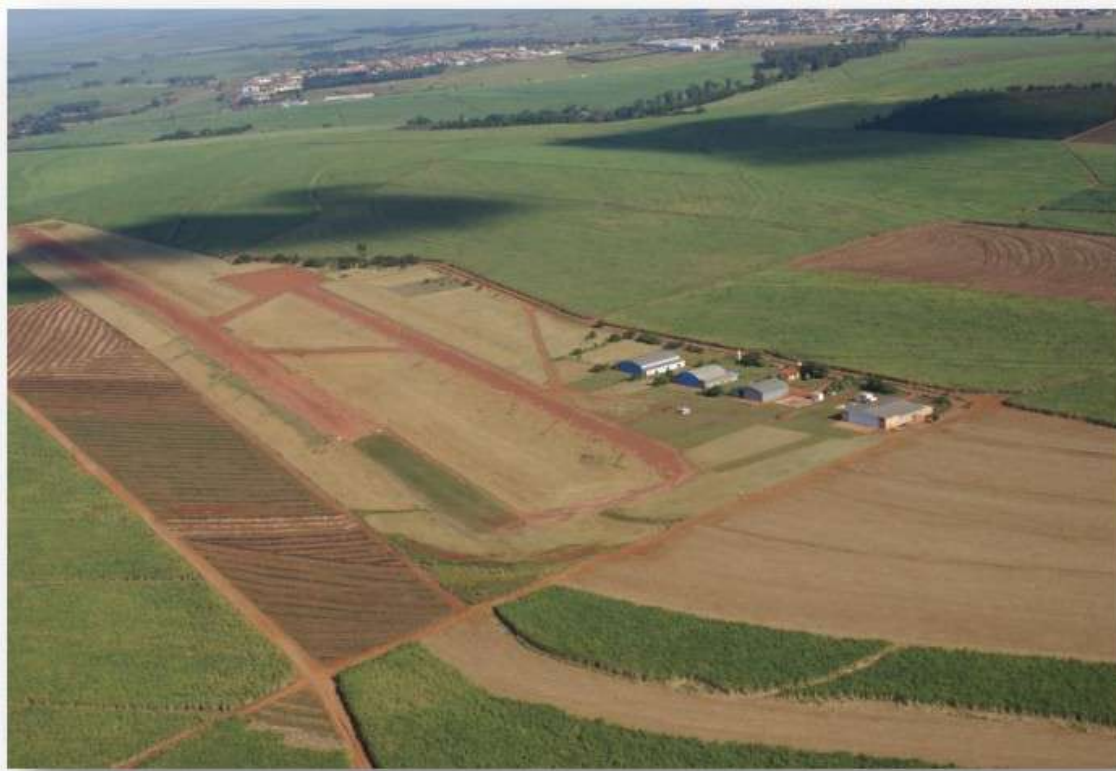
Foto 21 - Vista do Aeroporto de Pederneiras
