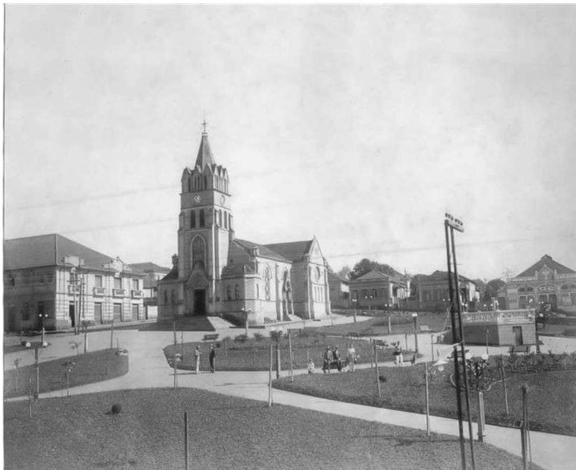
Foto 4 - Igreja São Sebastião recém-construída - fonte: www.pederneiras.sp.gov.br
