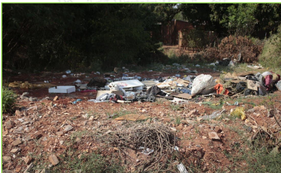
Figura 16 - Ponto de descarte irregular de resíduos no Córrego do Alegrete.
