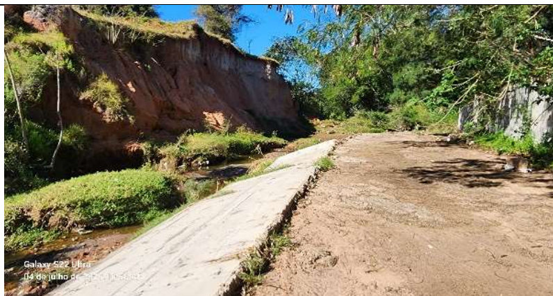
Figura 7 – Vista do final da canalização aberta do córrego do Alegrete Fonte: próprio autor
