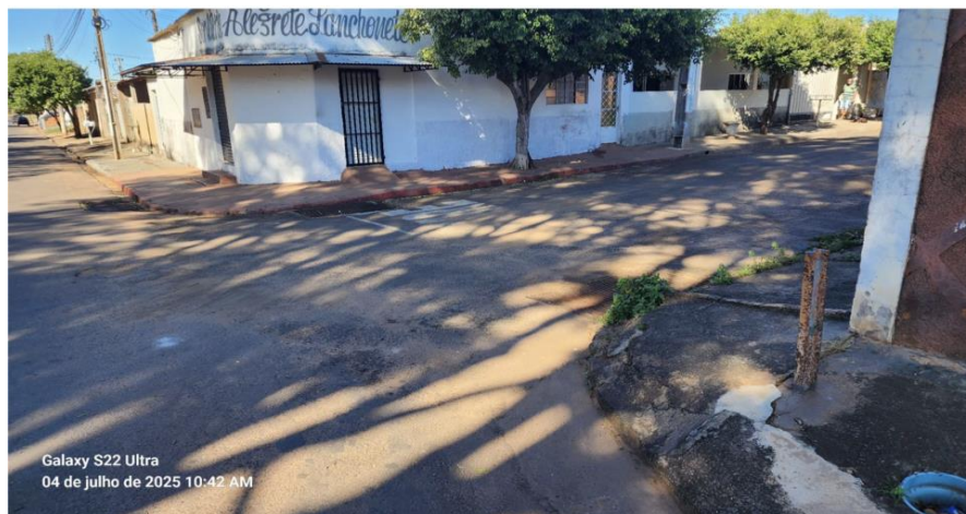
Figura 5 – Vista do sarjetão, grelha de captação de água e local apropriado para a instalação de uma vala de infiltração. Fonte: registro próprio.
