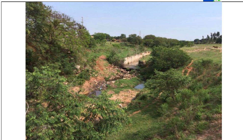
Figura 10 – Seção final da canalização do córrego Alegrete Fonte: Autor, 2017
