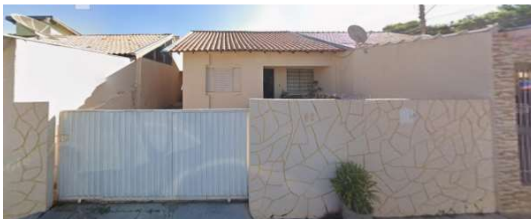
Vista frontal do imóvel.
