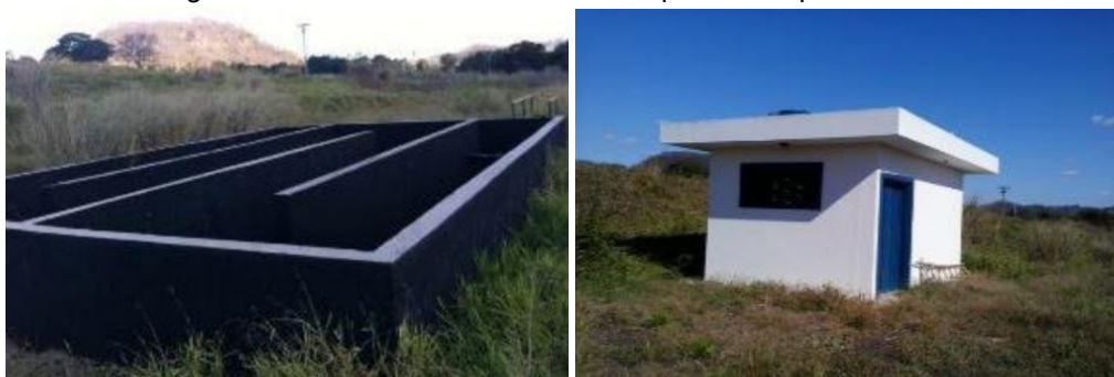
Figura 180 e 181. Chicanas e casa de química respectivamente
