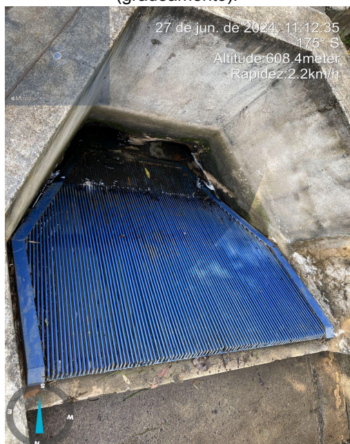
Figura 80: Sistema de tratamento d'água (gradeamento).
