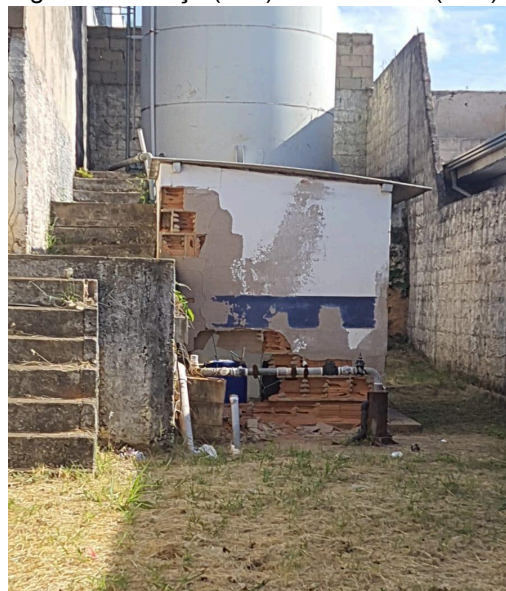
Figura 128: Poço (P11) Reservatório (R12).
