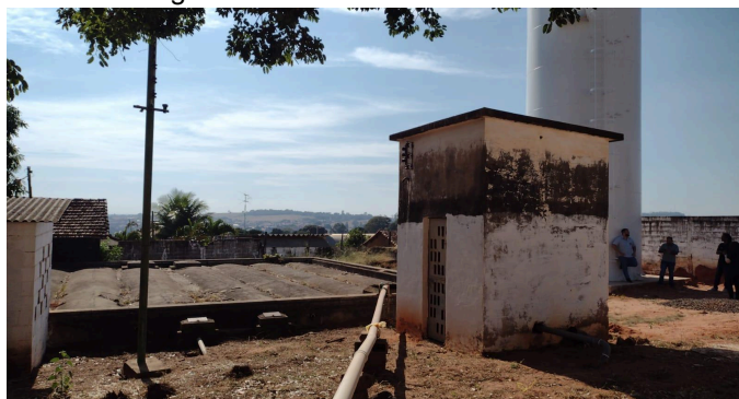
Figura 60: Reservatórios do Ponto 2.
