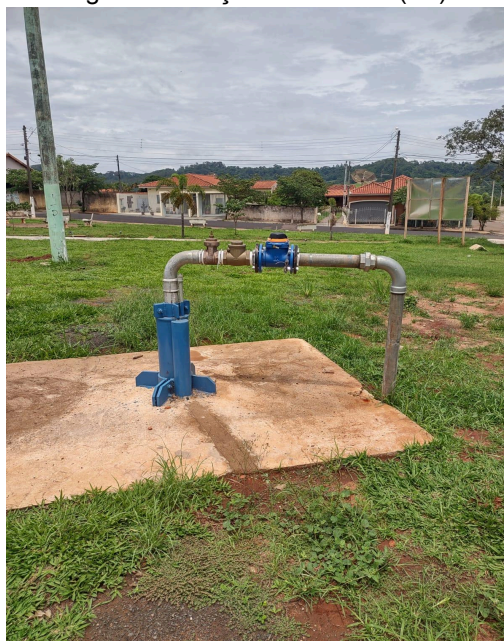
Figura 73: Poço subterrâneo (P4).
