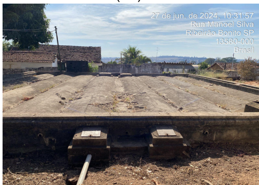
Figura 61: Reservatório semi-enterrado (R1).
