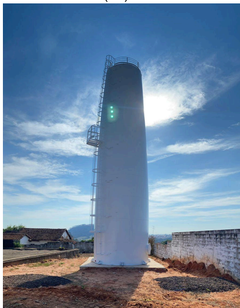
Figura 63: Reservatório elevado metálico (R2).
