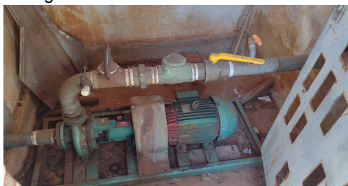
Figura 69: Bomba de abastecimento.
