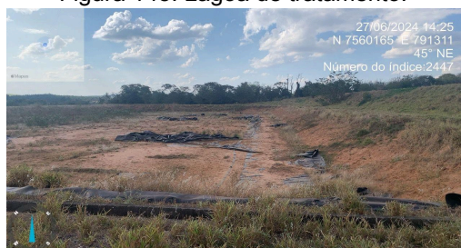
Figura 145: Lagoa de tratamento.
