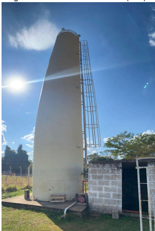
Figura 131: Reservatório elevado (R13).
