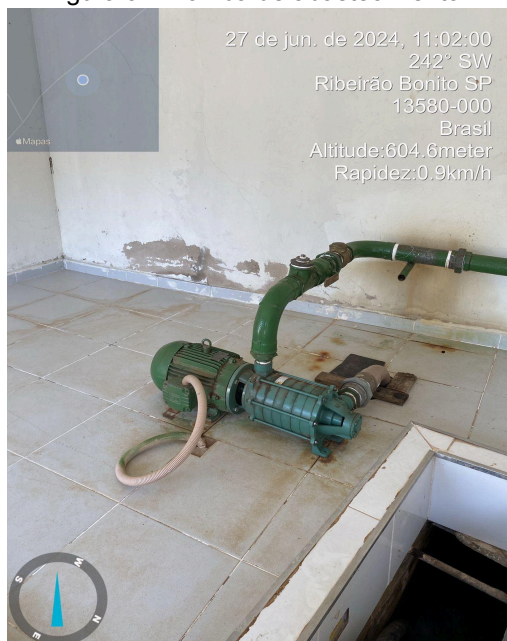
Figura 92: Bomba de abastecimento.
