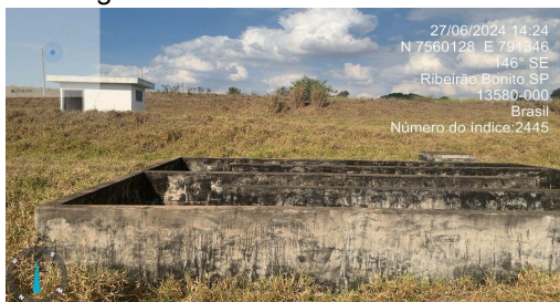
Figura 139: Estruturas da ETE 2.
