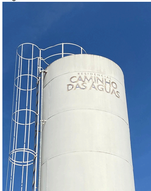
Figura 96: Reservatório elevado metálico.
