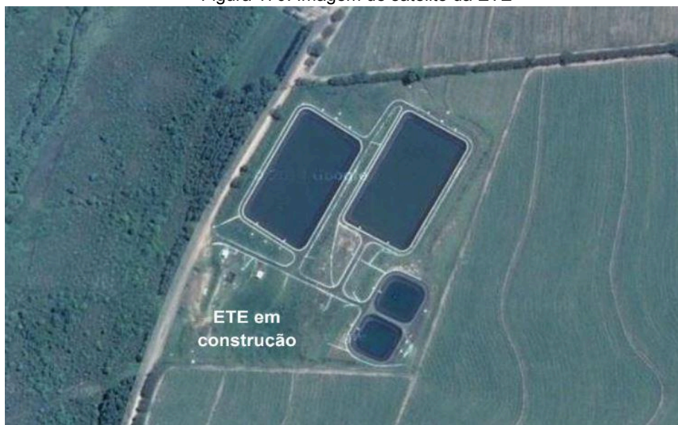
Figura 170: Imagem de satélite da ETE
