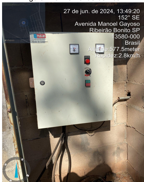
Figura 119: Painel de bomba.
