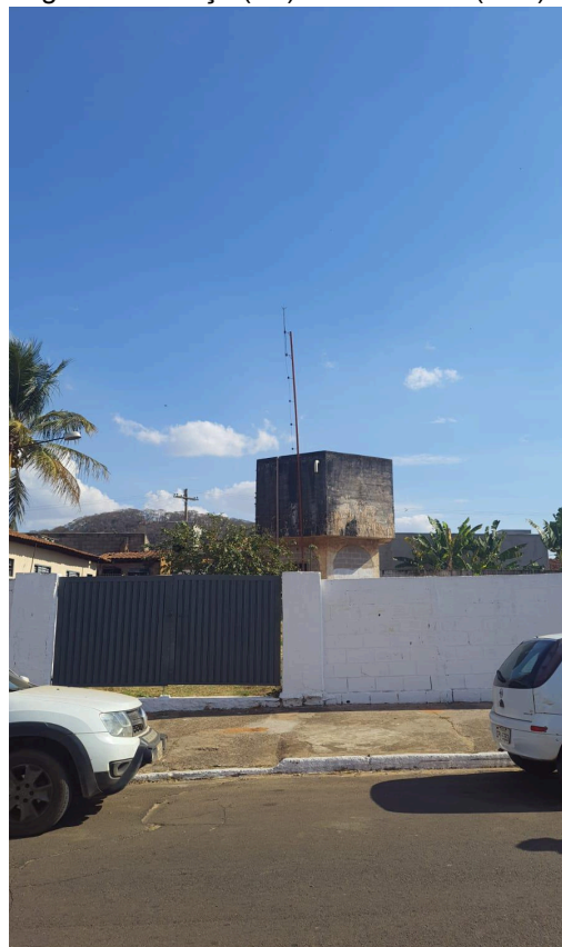
Figura 116: Poço (P9) Reservatório (R10).
