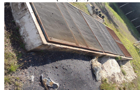
Figura 83: Sistema de tratamento d'água (Filtração).
